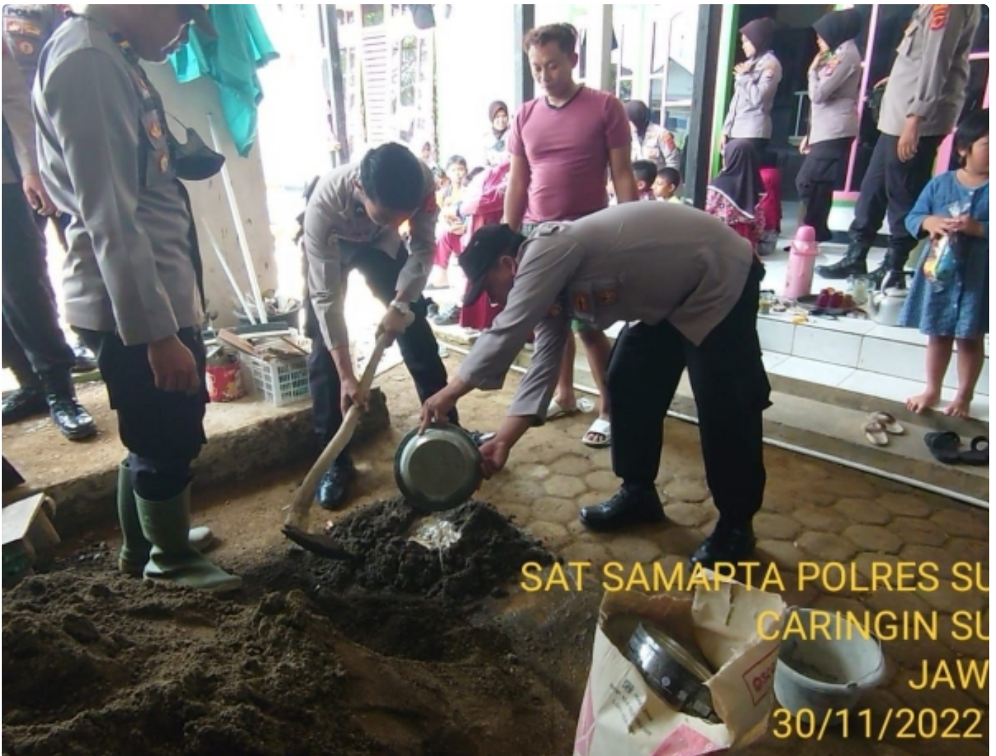
Kapolres Sukabumi Bantu Perbaiki Rumah Warga Yang Rusak Akibat Gempa
