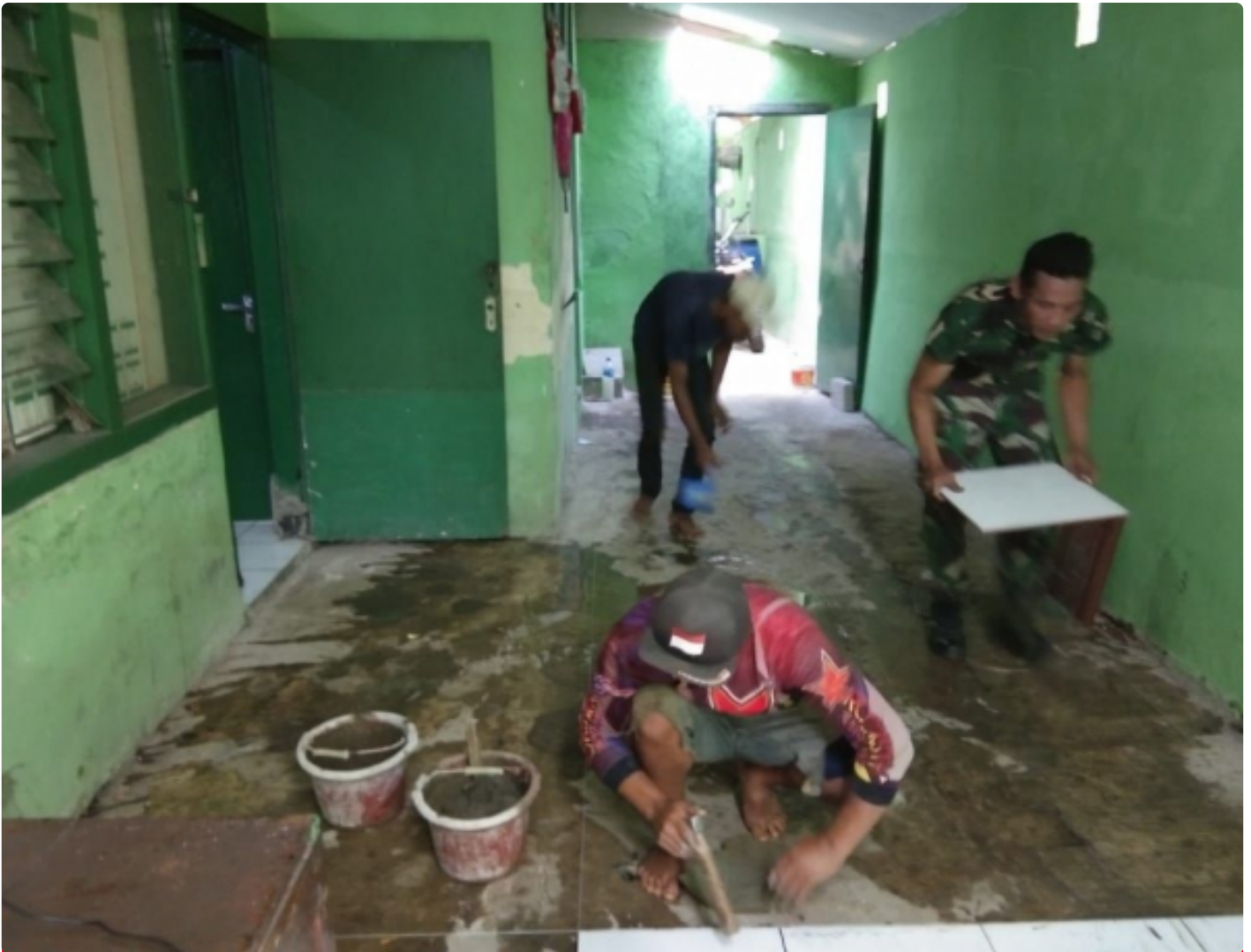
Koramil 0622-04/Cikidang Lakukan Perbaikan dan Pemeliharaan Kantornya
